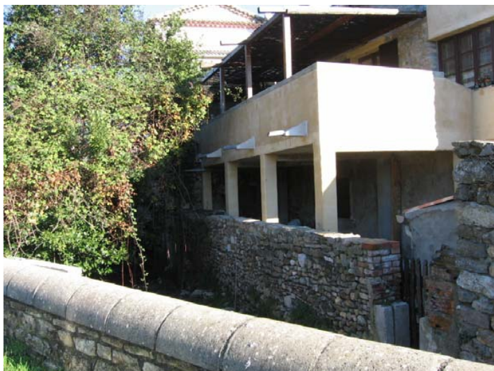
Habitation riveraine faisant office de digue latérale
