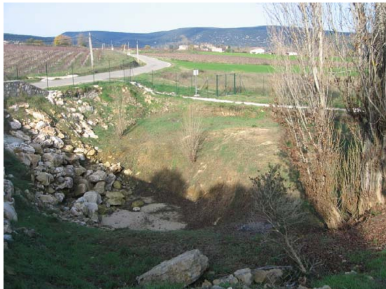
Captage d'eau dans une résurgence karstique
