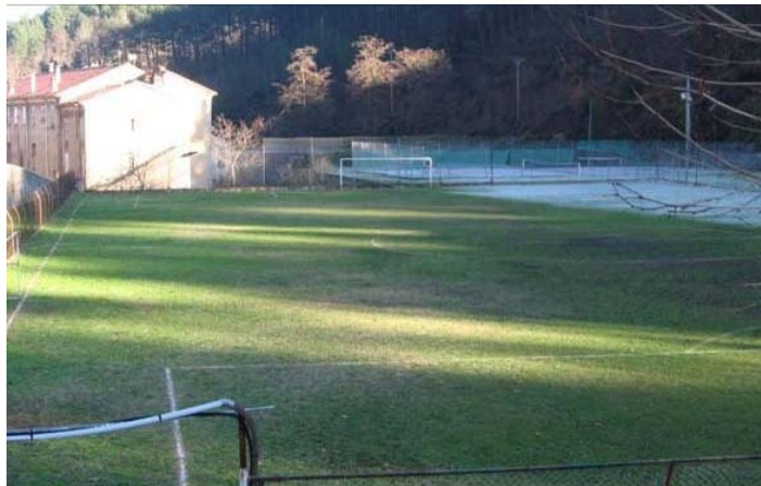
Terrain de football construit sur remblai
