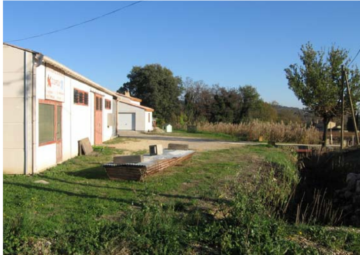
Constructions récentes vulnérables aux Prats
